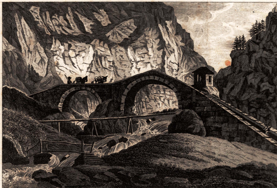
Brücke von Campo Dolcino am Fuße des Splügens.
